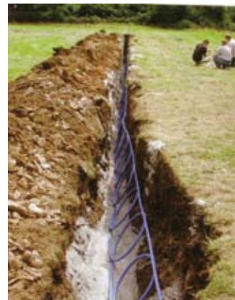
Рис. 7. Slinky-теплообменник
