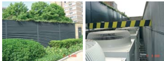
Внутри этого декоративного сооружения размещены наружные блоки
