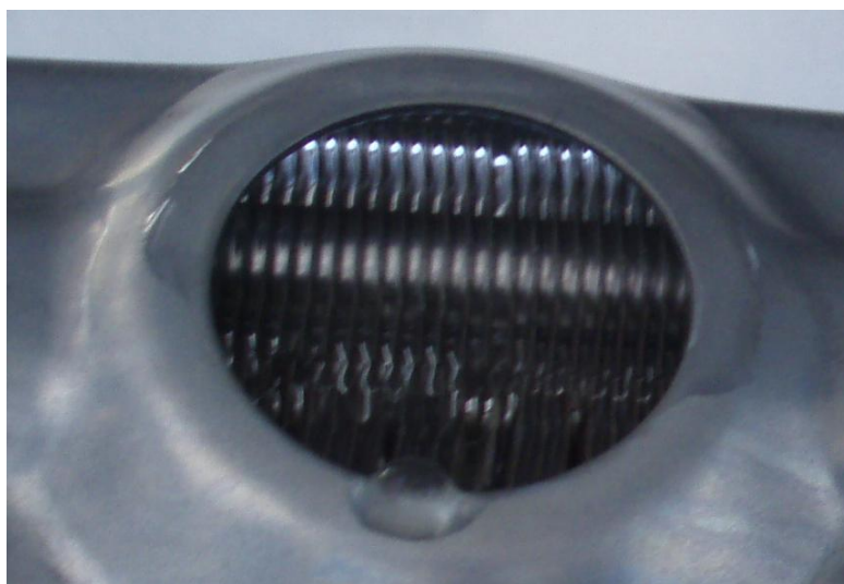
Фото 4. Состояние теплообменника наружного блока после оттайки.
