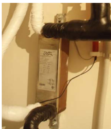
Фото 2. Пластинчатый теплообменник фреон-вода.
