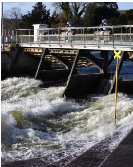
Wehre sind unerlässlich zur Regelung der Fließgeschwindigkeit.
