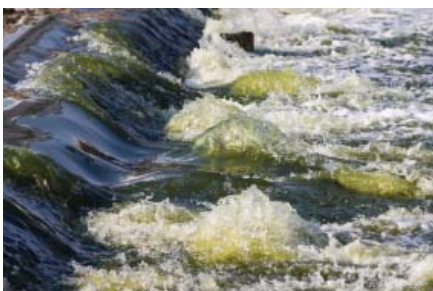
System zur Wehrsteuerung
