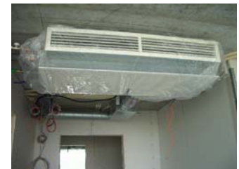
Рис. 3. Место для установки калорифера, внутренний блок.
