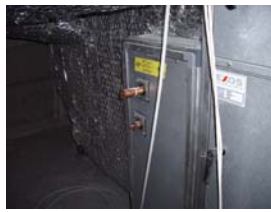
Рис. 5. Тепловые насосы, фреоновая секция, рекуператор.
