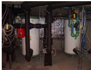
Рис. 3. Приточные установки, насосы и емкости горячей воды.
