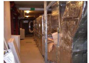
Рис. 3. Приточные установки, насосы и емкости горячей воды.
