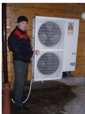
Фото 3. Процесс монтажа ZUBADAN на коттедже
