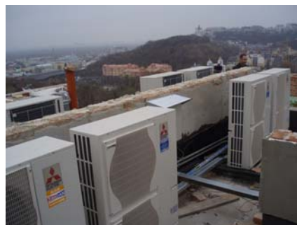
Фото 2. Компрессорно-конденсаторные блоки.
