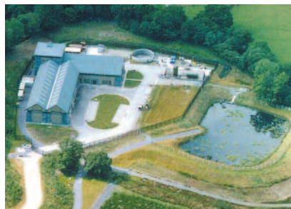
Station de pompage isolée.
